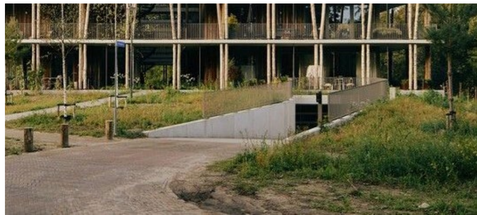
entree parkeergarage verscholen in de helling
